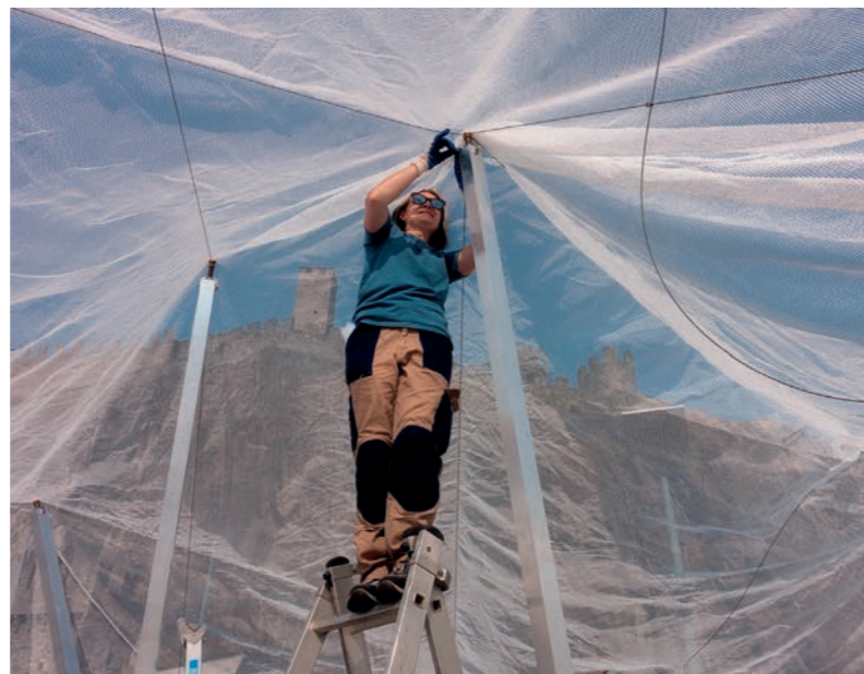
▲ Monica Sciarini, direttore-timoniere e consorte di Nicola Colombo Allestimento "La Nuvola Piovasca" | Tensostruttura in alluminio 15m x 8m x 4m, cordine in acciaio, rete a maglia aperta in polietilene, nebbia naturale.
